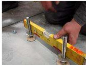
1. Vissez les écrous de réglage inférieurs sur leurs ancrages au sol et placez les rondelles sur les écrous.
