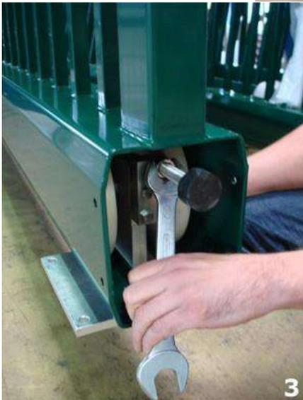
3. Desserrez le contre-écrou. Tournez la tige filetée dans le sens inverse des aiguilles d'une montre de manière que la butée en caoutchouc sorte de la poutre de soubassement de 0,5 à 1,0 cm. Bloquez la tige filetée à l'aide du contre-écrou.
