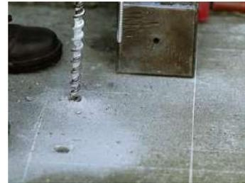
2. Marquez la position des trous avec un foret à béton de petit diamètre. Cela facilitera le centrage du foret final.
