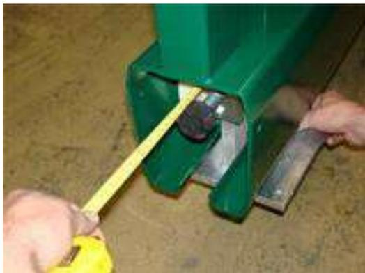
Si le portail est installé correctement suivant les plans de fondation, la butée avant n'a pas besoin d'être ajustée. Le réglage d'usine (13 cm) sera suffisant.
