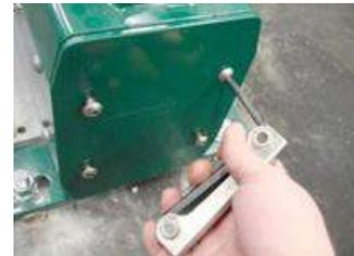
2. Fermez le vantail de façon à avoir une distance de 1,0 à 2,0 cm entre les roulettes de guidage supérieures sur le haut du vantail et le fond du V de réception du portique de réception.
